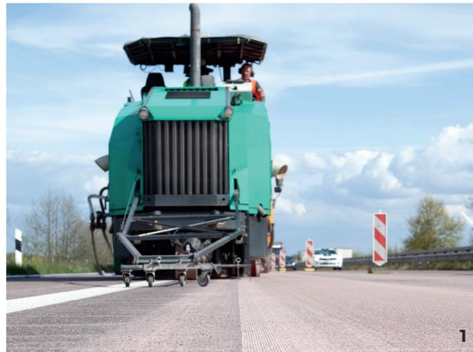
1 Herstellung Bahn an Bahn – patentierte Steuerungstechnik über Abtastung | 2 Grinding-/Groovingwelle – variable Zusammensetzung für optimiertes Oberflächendesign | 3 moderne Mess- und Steuertechnik – Erhöhung Prozess-/Produktqualität
